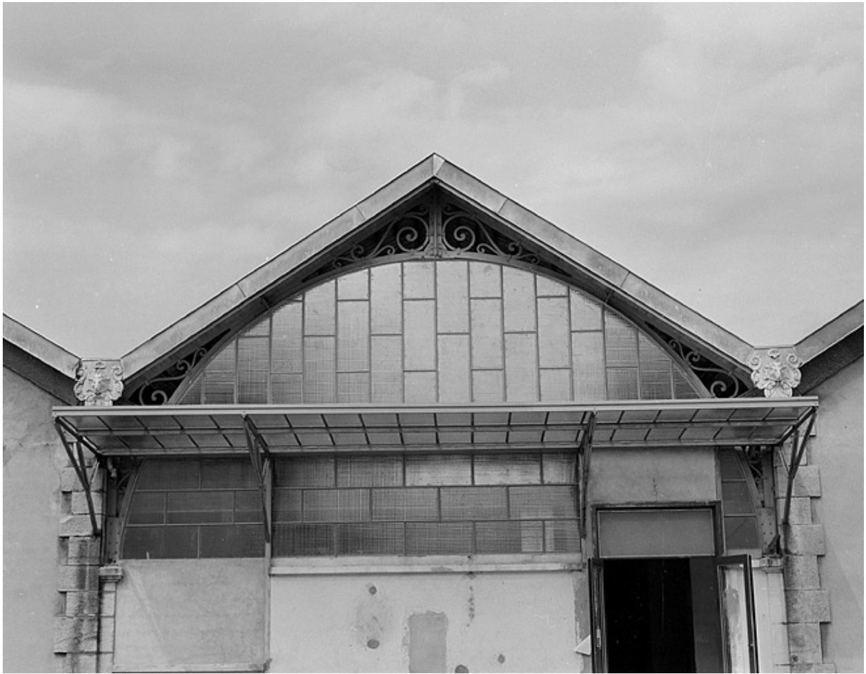
Détail de la couverture de la halle.
