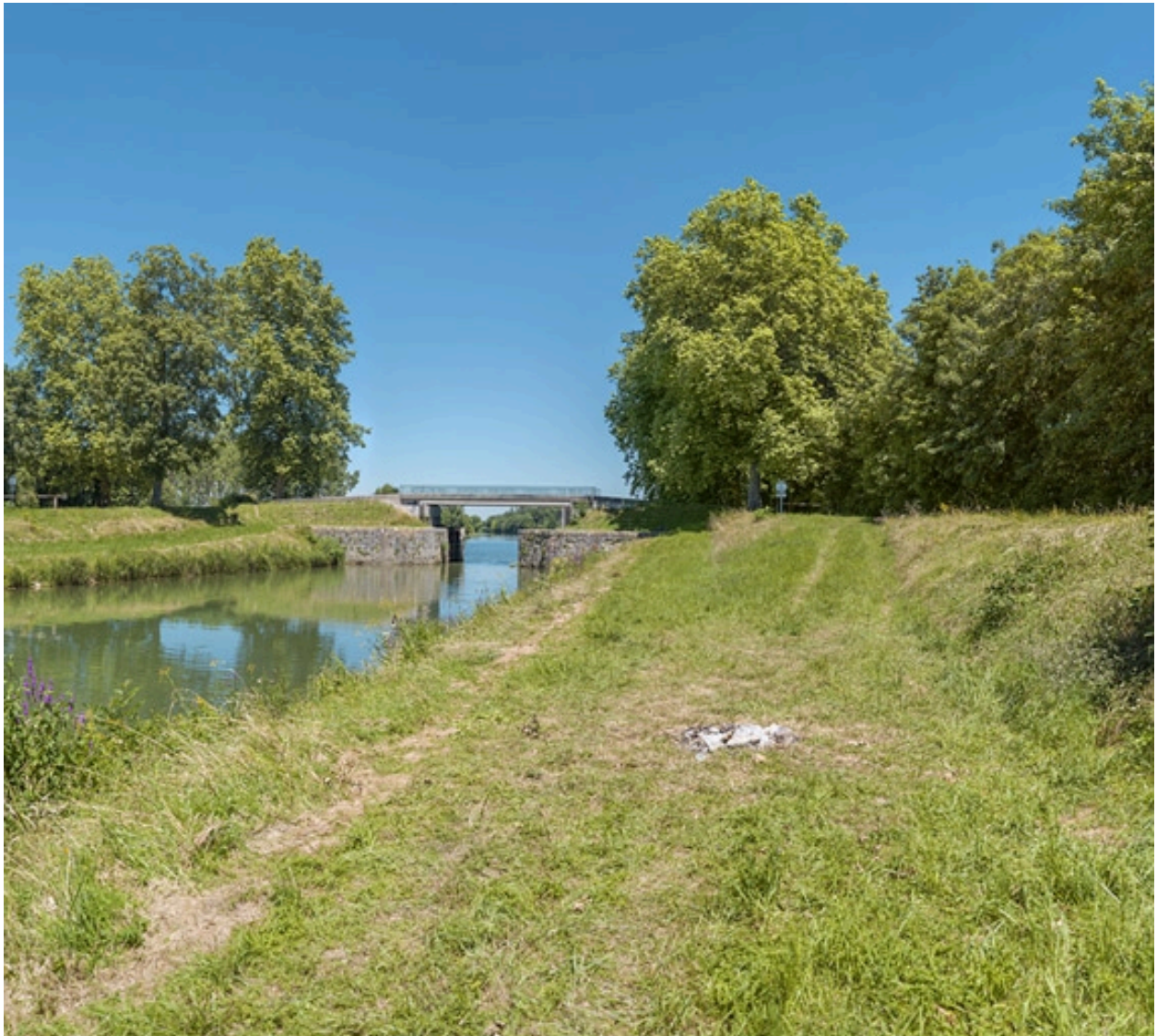
Vue d'ensemble d'aval.
