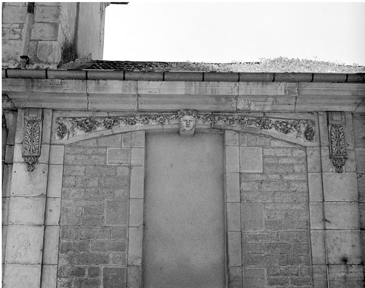
Détail du mur d'enclos côté Grande Rue.
