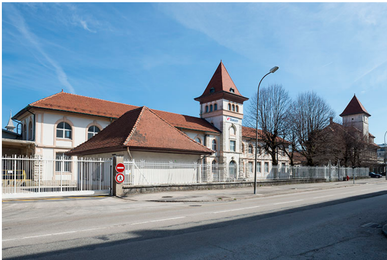
Bâtiments d'entrée, depuis l'ouest.
