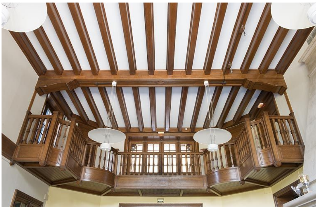
Mezzanine du salon.
