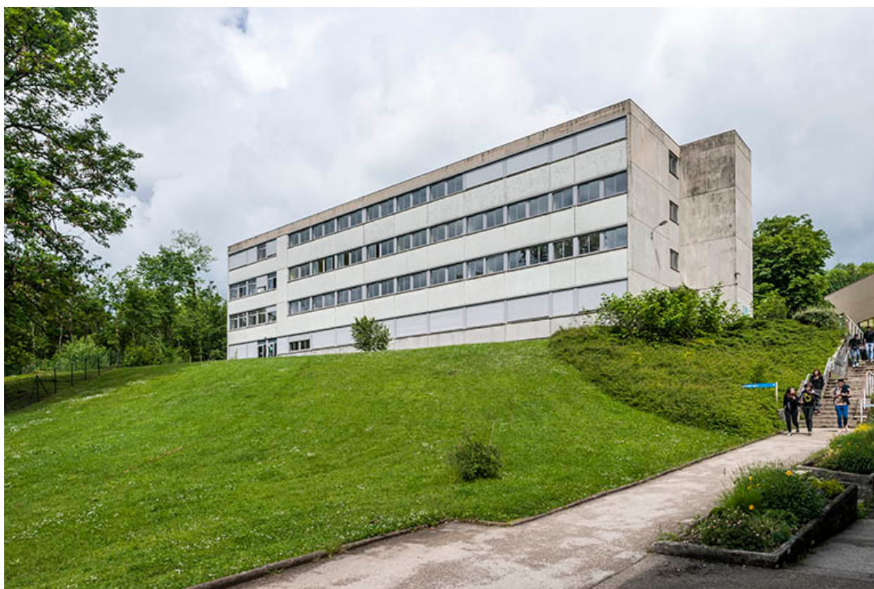
Façade sud de l'internat de garçons.
