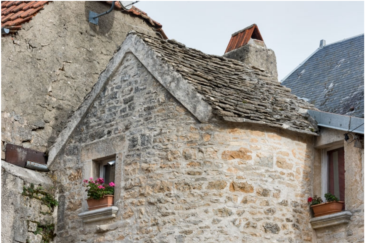
Détail de la toiture côté nord-ouest.
