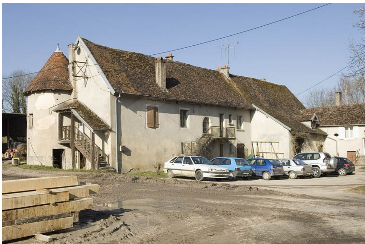
Logis sud. Vue de trois quarts.
