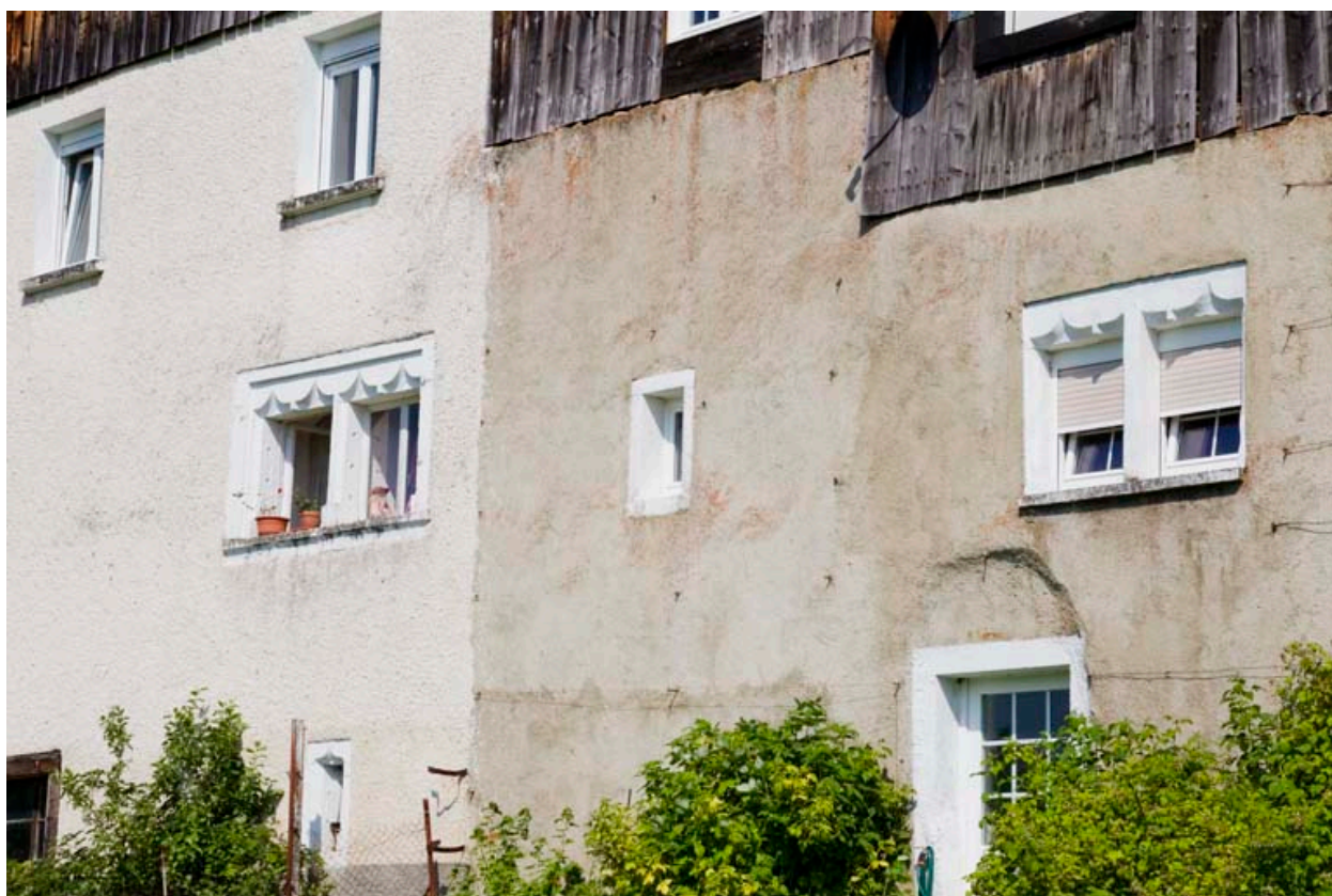
Façade latérale droite : baies.
