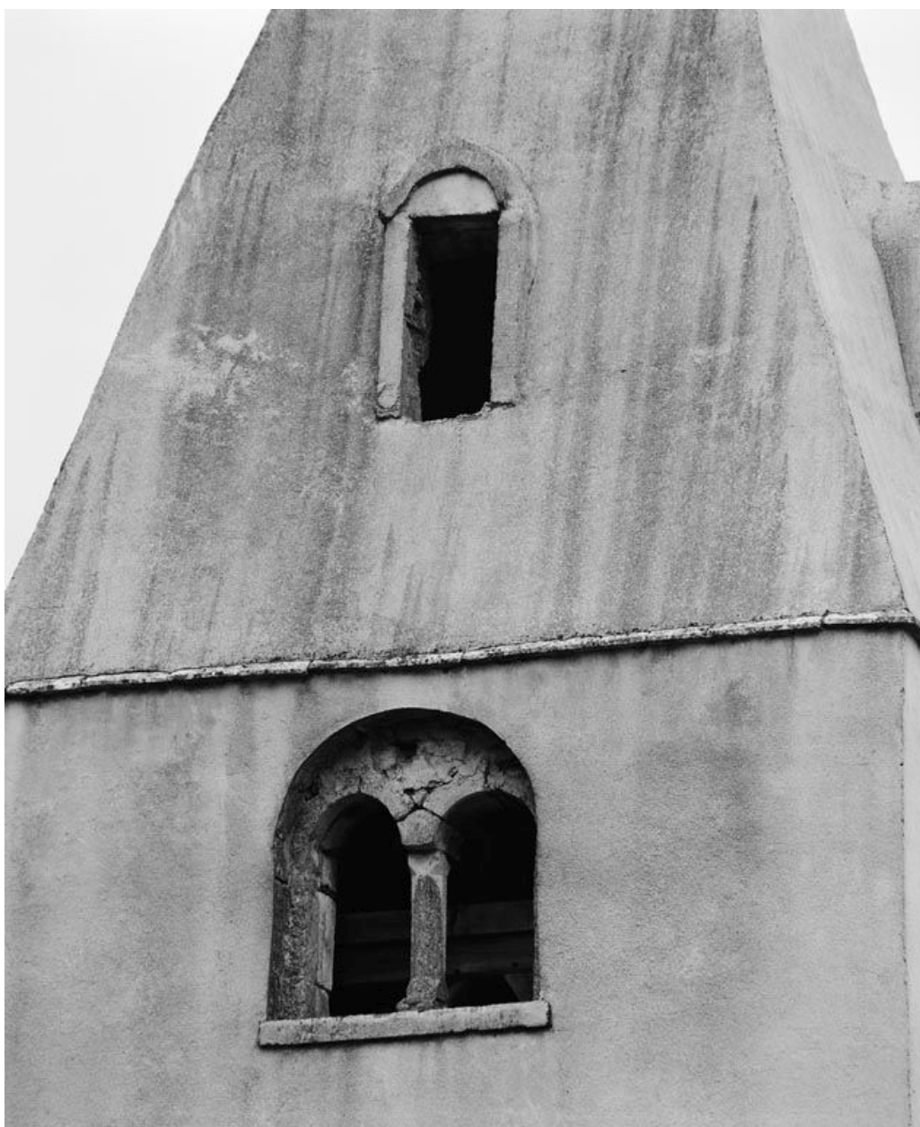
Détail des baies antérieures du clocher.
