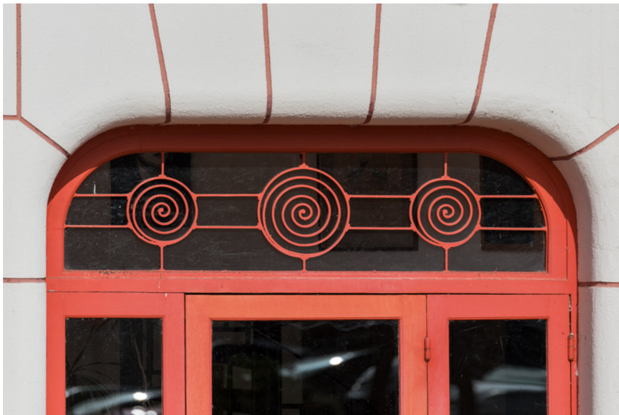
Façade antérieure : ferronnerie de la baie centrale.
