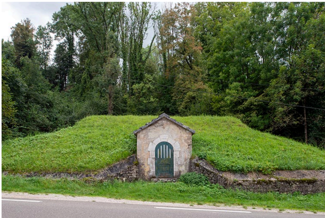
Réservoir de Veley (1910). Vue de face.
