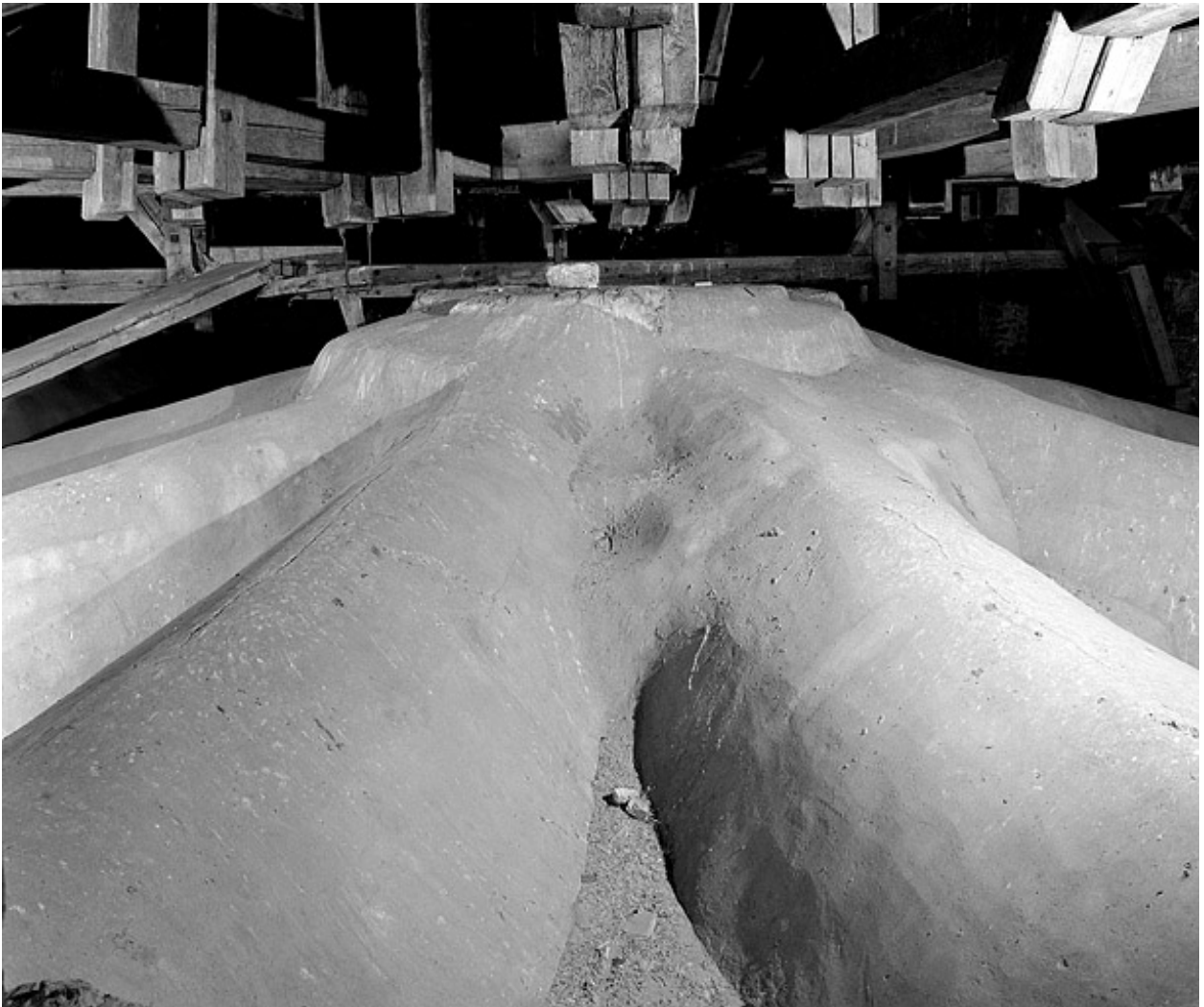
Intrados de la clef de voûte de l'abside.
