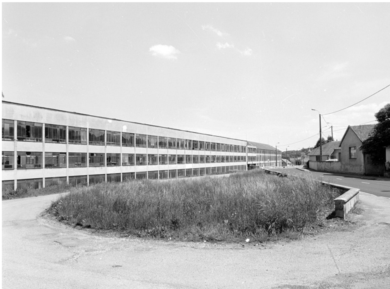
Alignement des façades sud.
