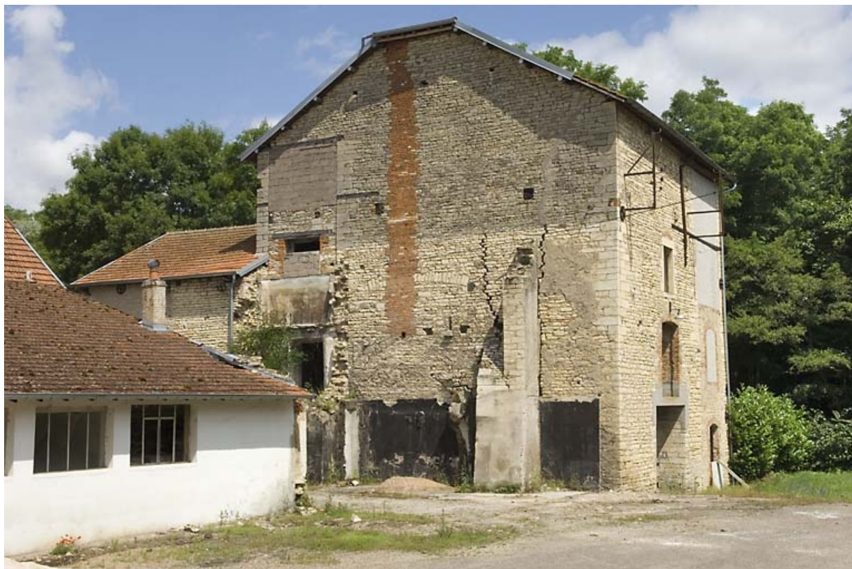
Le haut fourneau vu depuis le sud.
