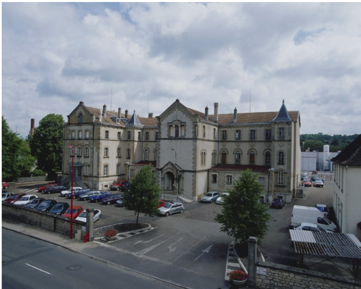
Vue d'ensemble de l'ancien couvent (actuellement bureaux).
