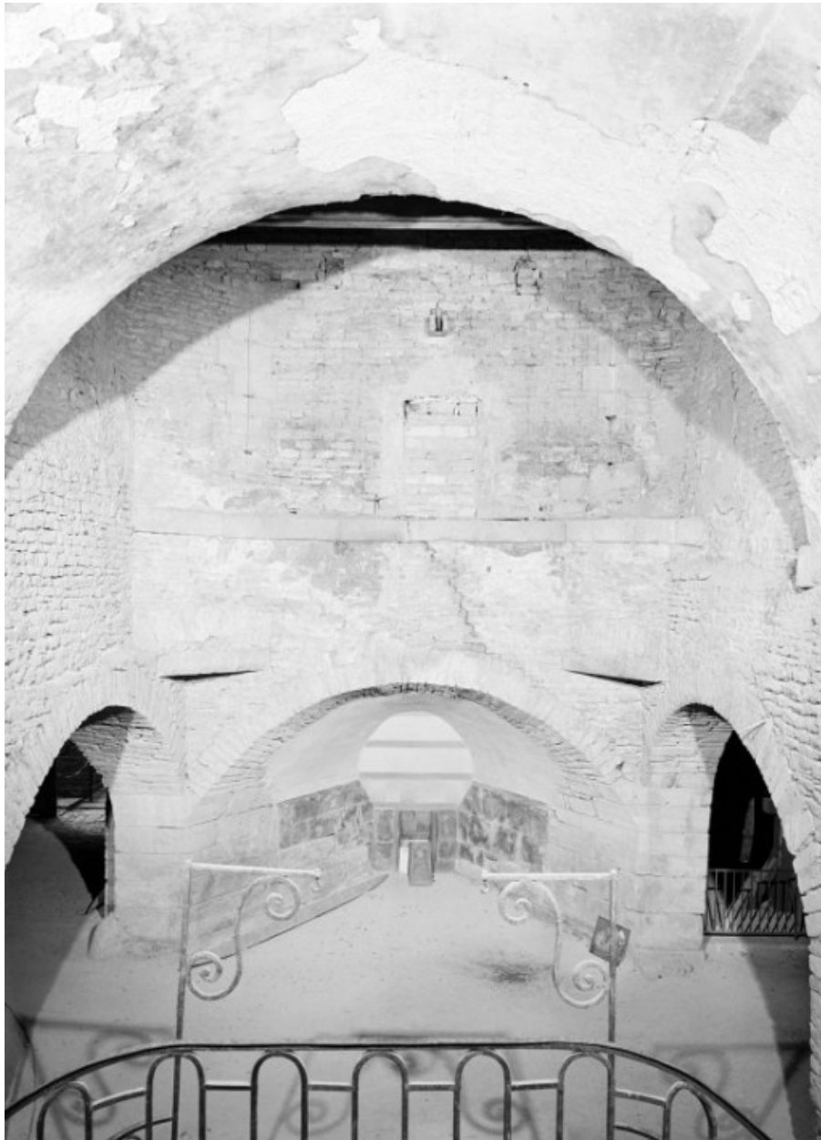
Haut fourneau, halle de coulée, vue prise de l'escalier d'honneur.
