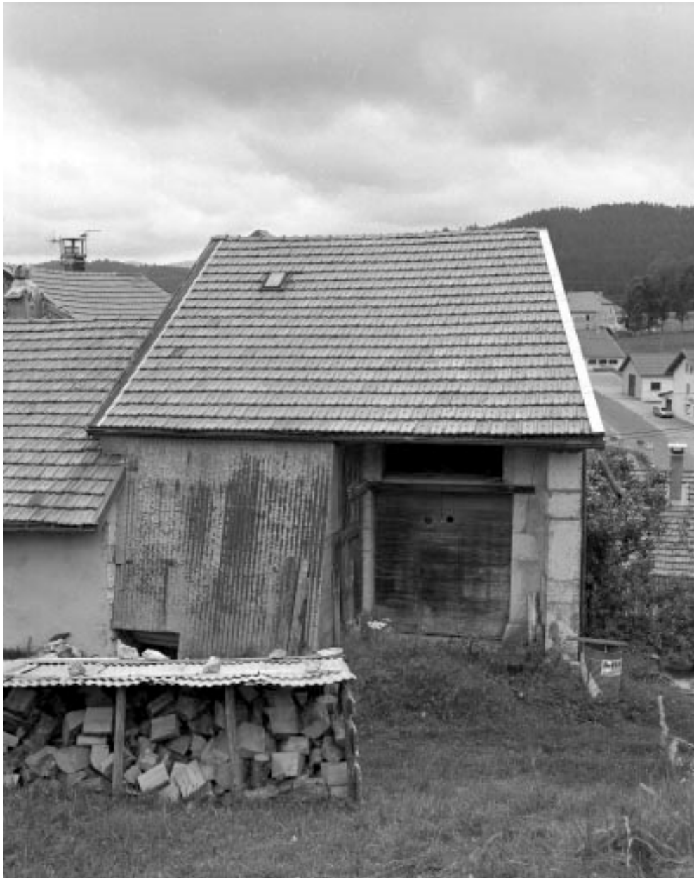
La rue Derrière, accès à une grange.
