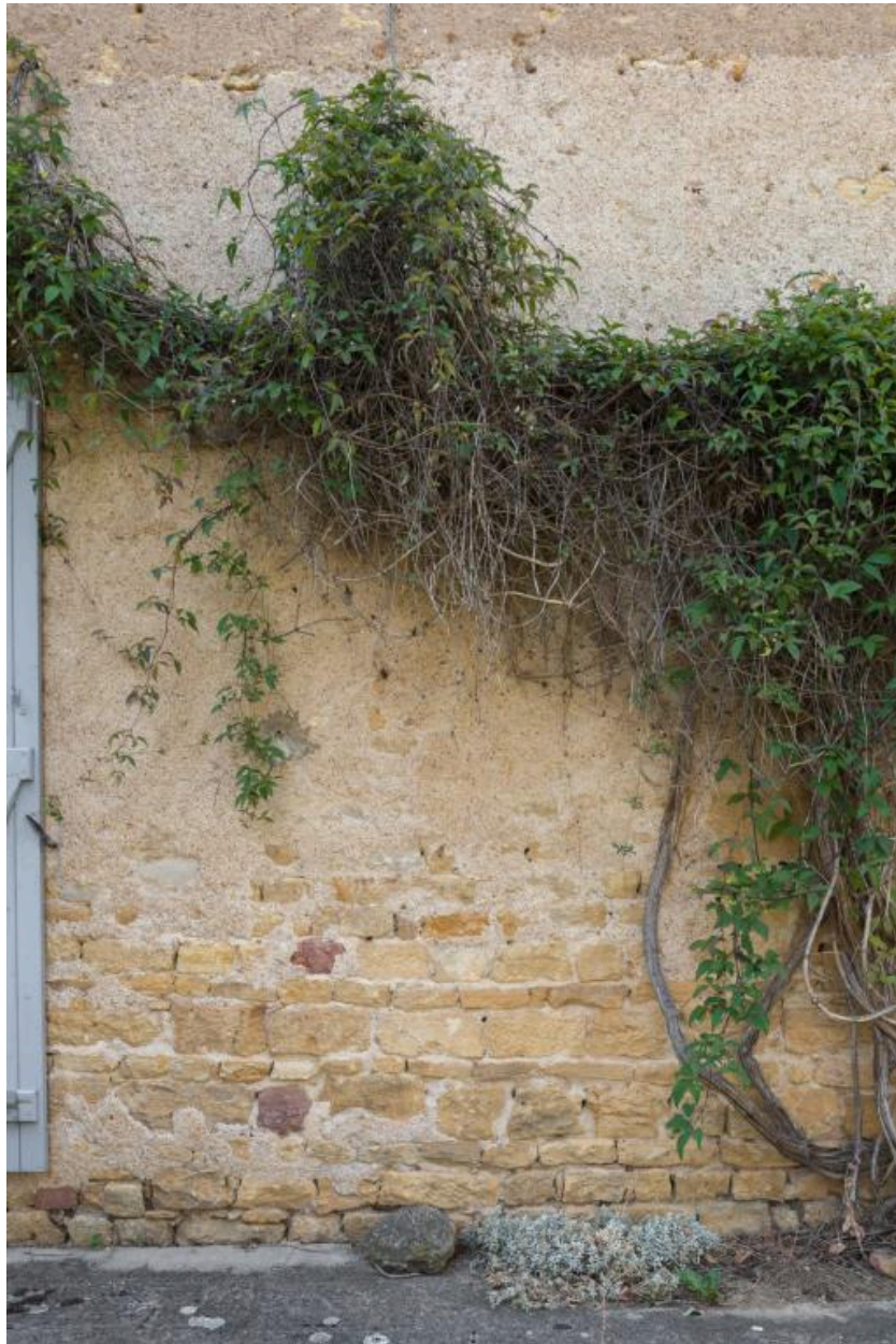
Détail de la façade antérieure de la maison : maçonnerie
