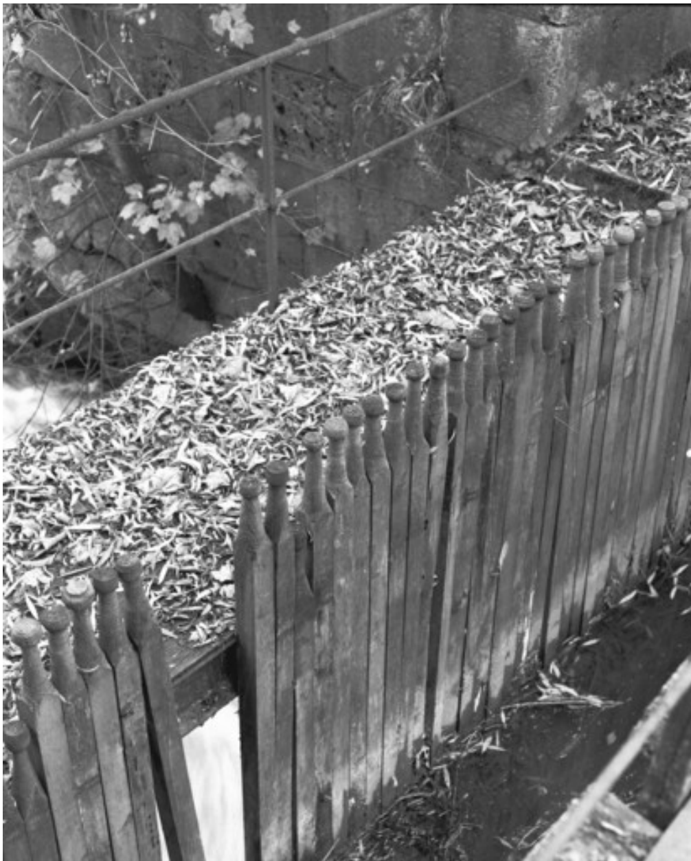
Détail des aiguilles du barrage en 1989.
