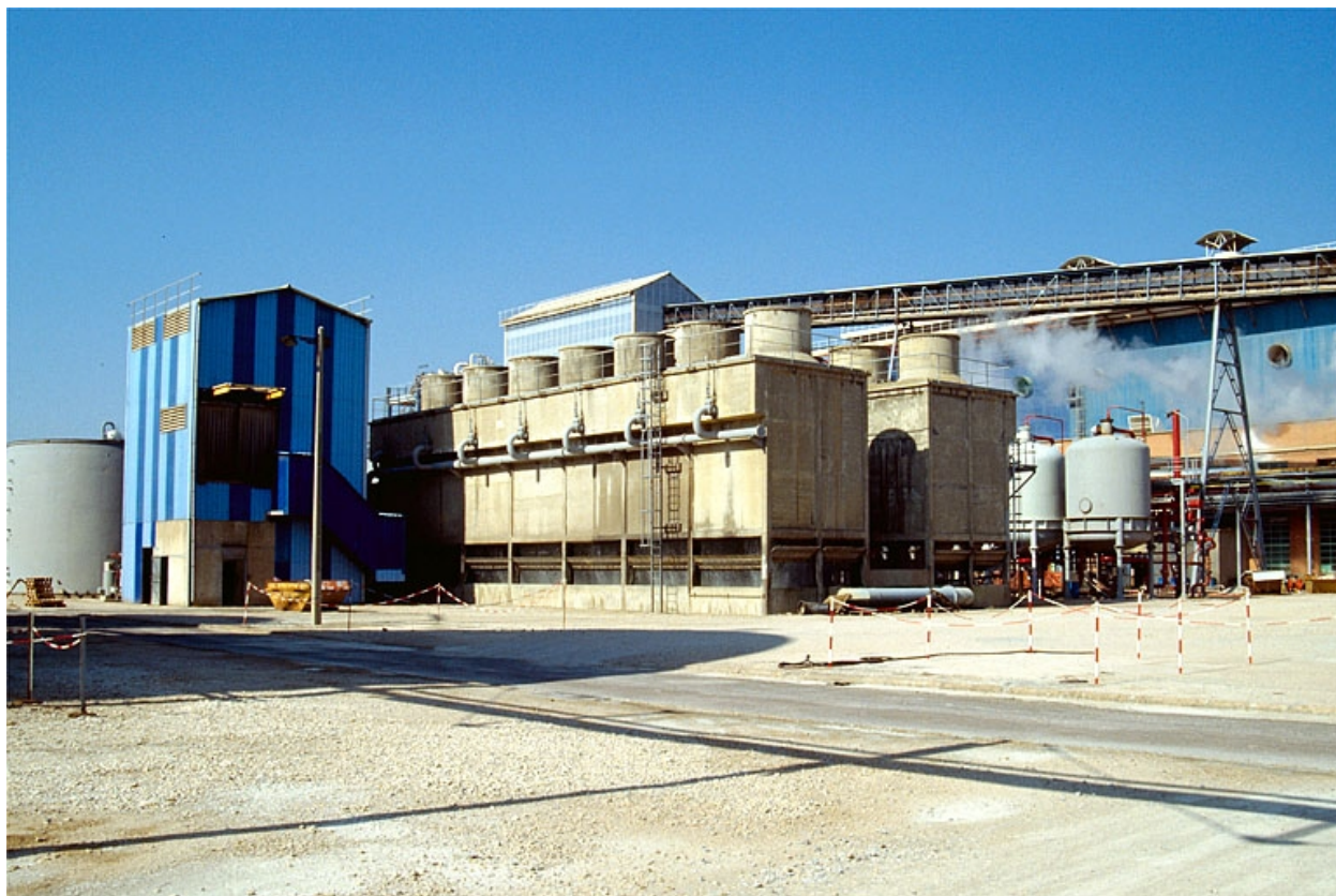
Tours de réfrigération (38) de l'usine d'électrolyse.
