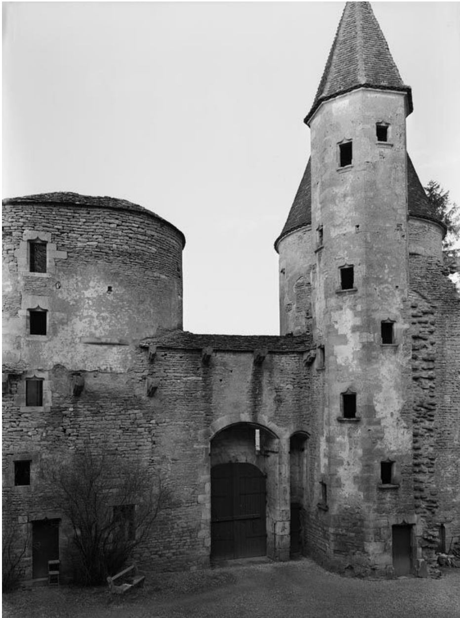
Le dispositif d'entrée. Vue de l'intérieur (photo prise en 1969).
