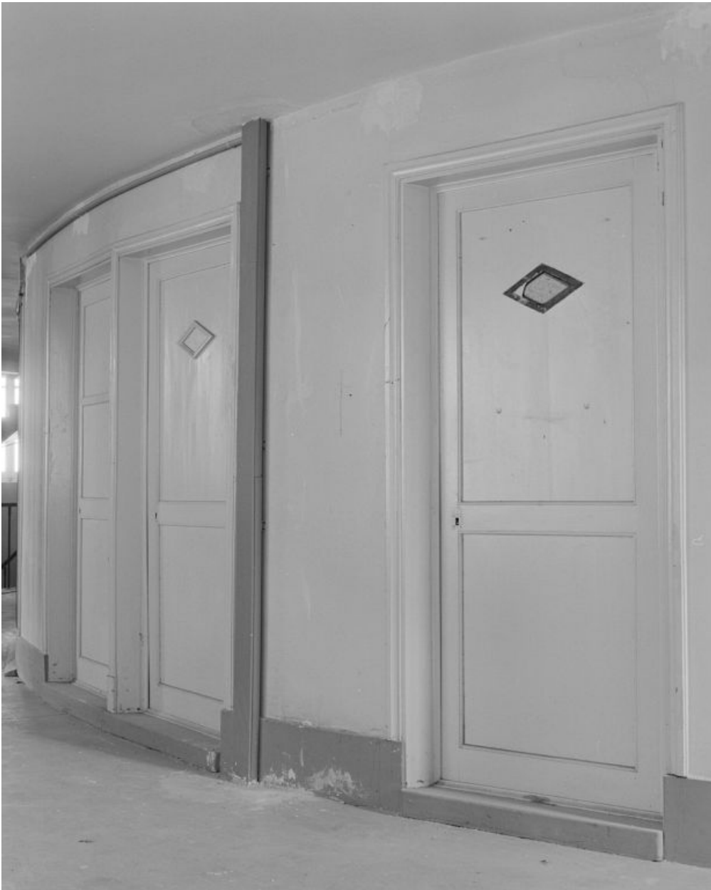
Couloir dont les portes donnent accès à une galerie, en 1988.
