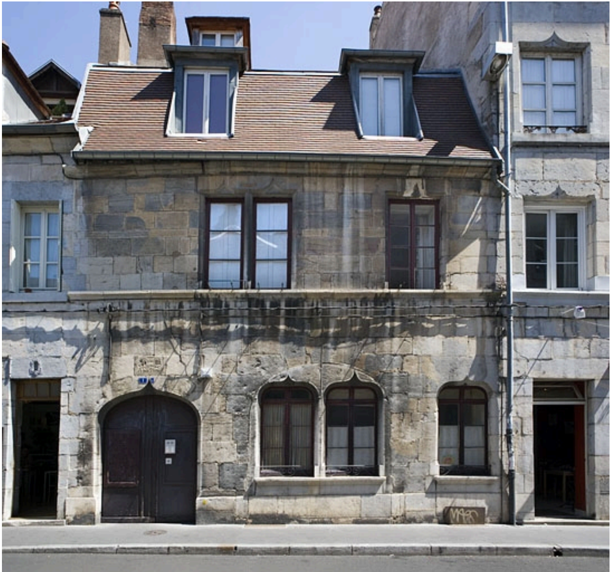
Vue d'ensemble de la façade sur rue : de face.
