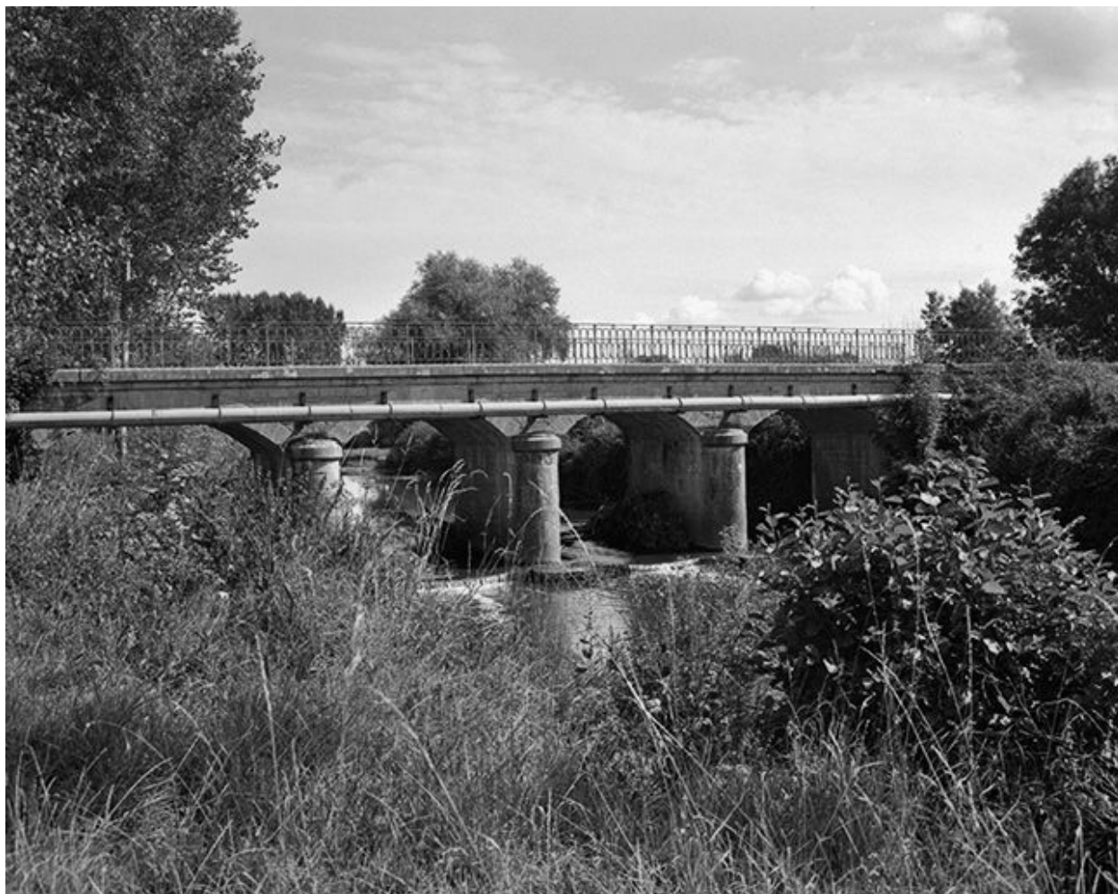
Courlaoux : pont sur la Vallière.
