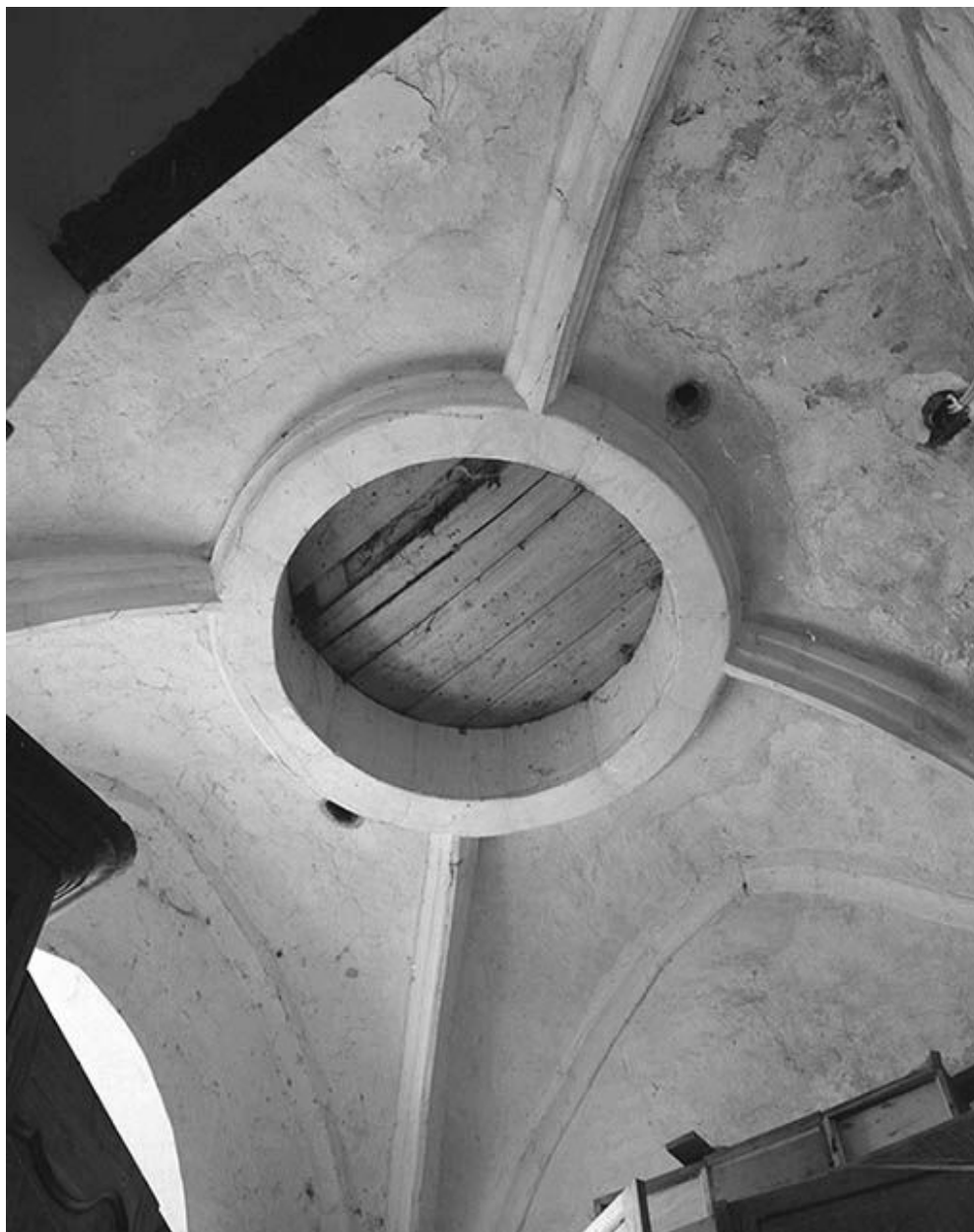
Clocher, niveau inférieur : voûte.
