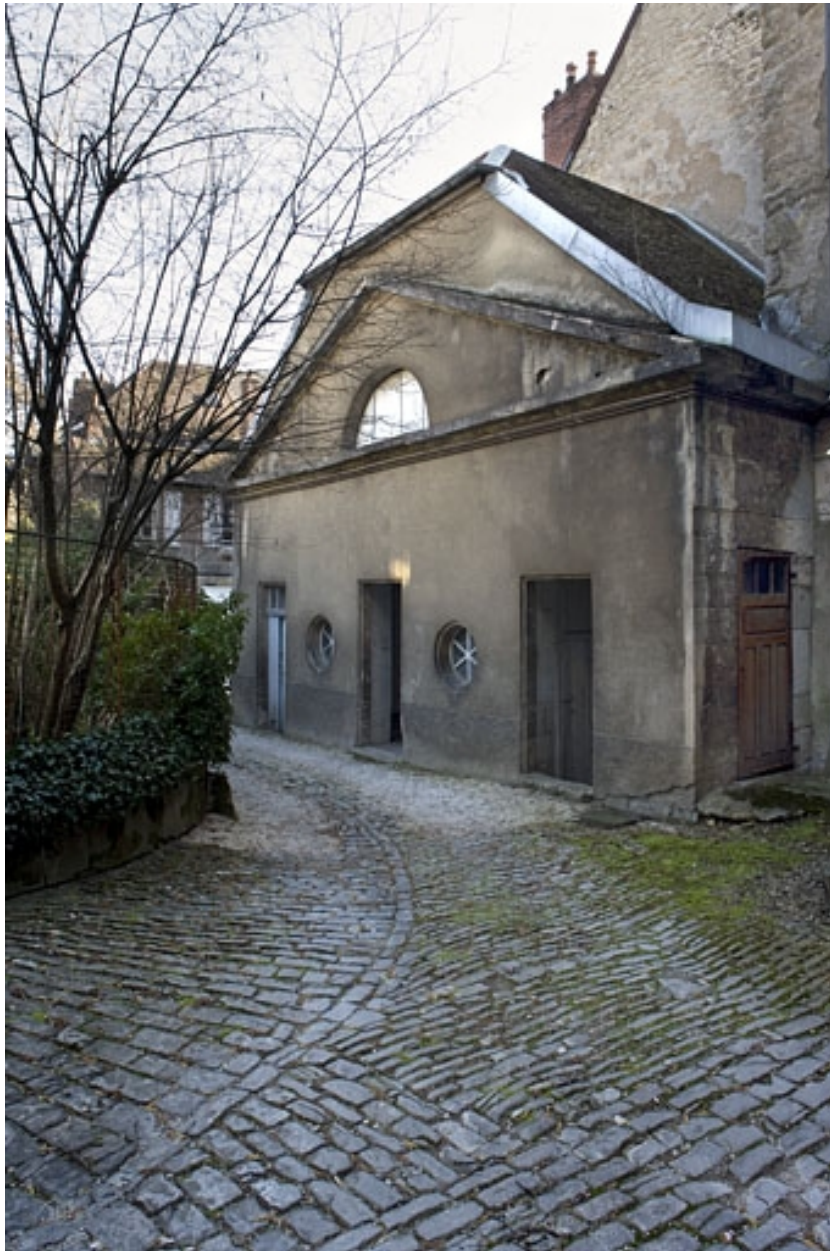
Vue d'ensemble du bâtiment des remise et écurie droit, de trois quarts droit.
