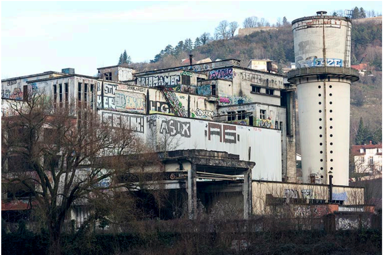
Etat en 2016. Usine A : extrémité orientale des ateliers d'étirage et filature tergal et nylon, avec le château d'eau, vus de trois quarts.
