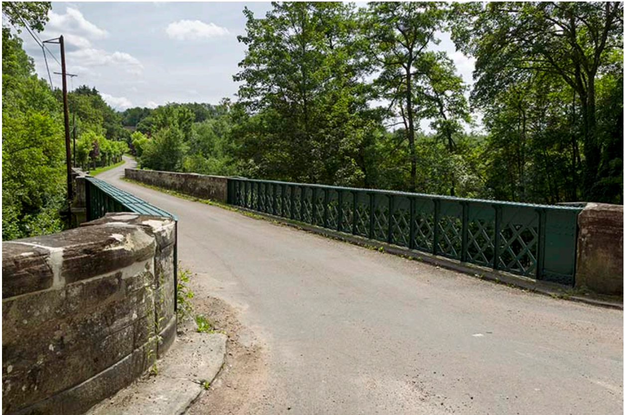
Vue de la passerelle depuis la route.
