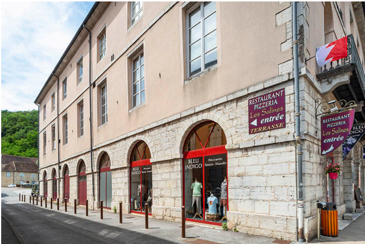
Façade sud, depuis la rue de la République.
