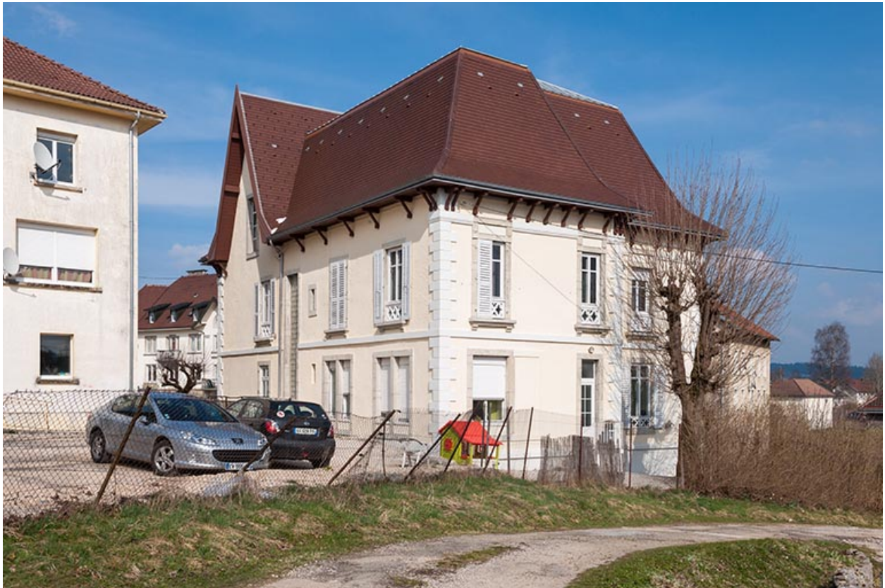
Logement patronal : façade postérieure, de trois quarts droite.
