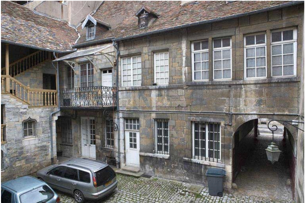
Vue d'ensemble de la façade postérieure du logis sur rue, de trois quarts droit.
