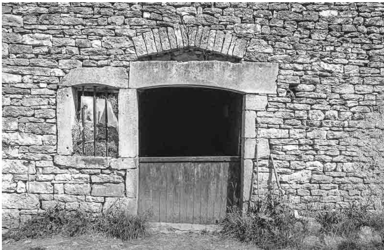
Détail : porte d'écurie sur façade latérale gauche.
