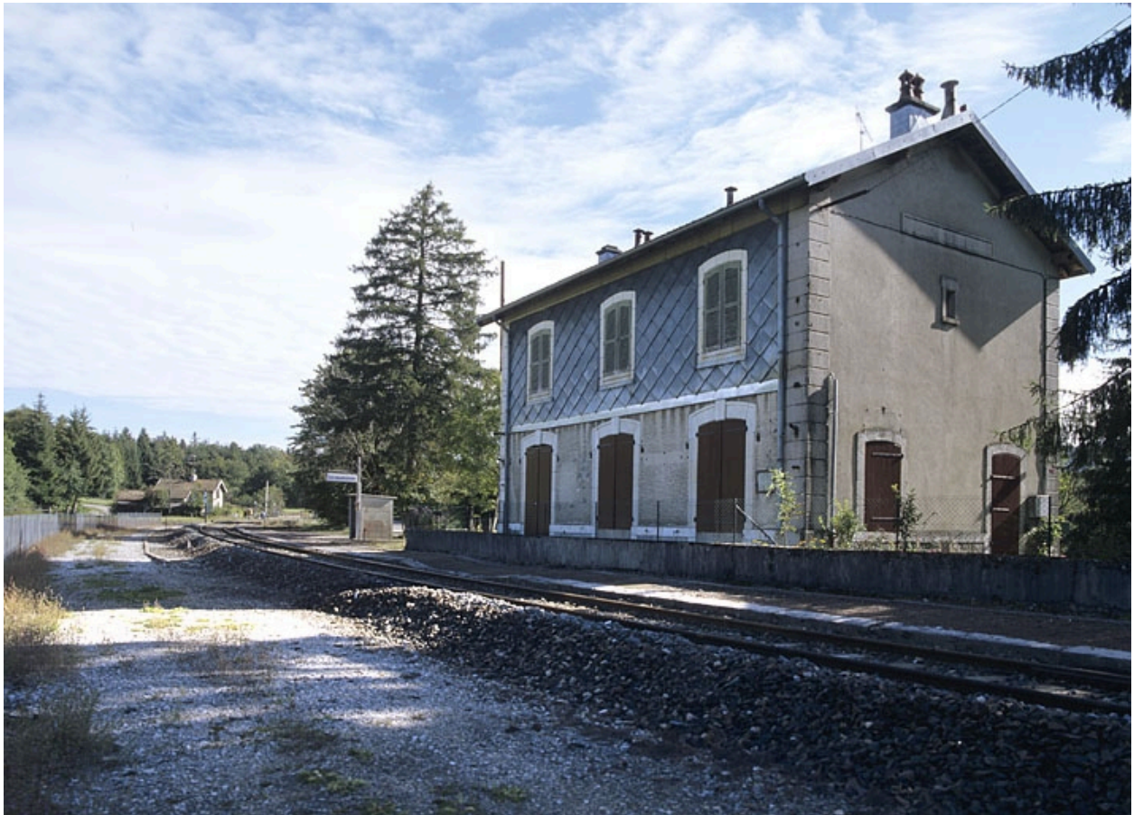
Exemple de gare PLM de 3e classe. Le Vaudioux (entre Champagnole et Saint-Laurent-en-Grandvaux).
