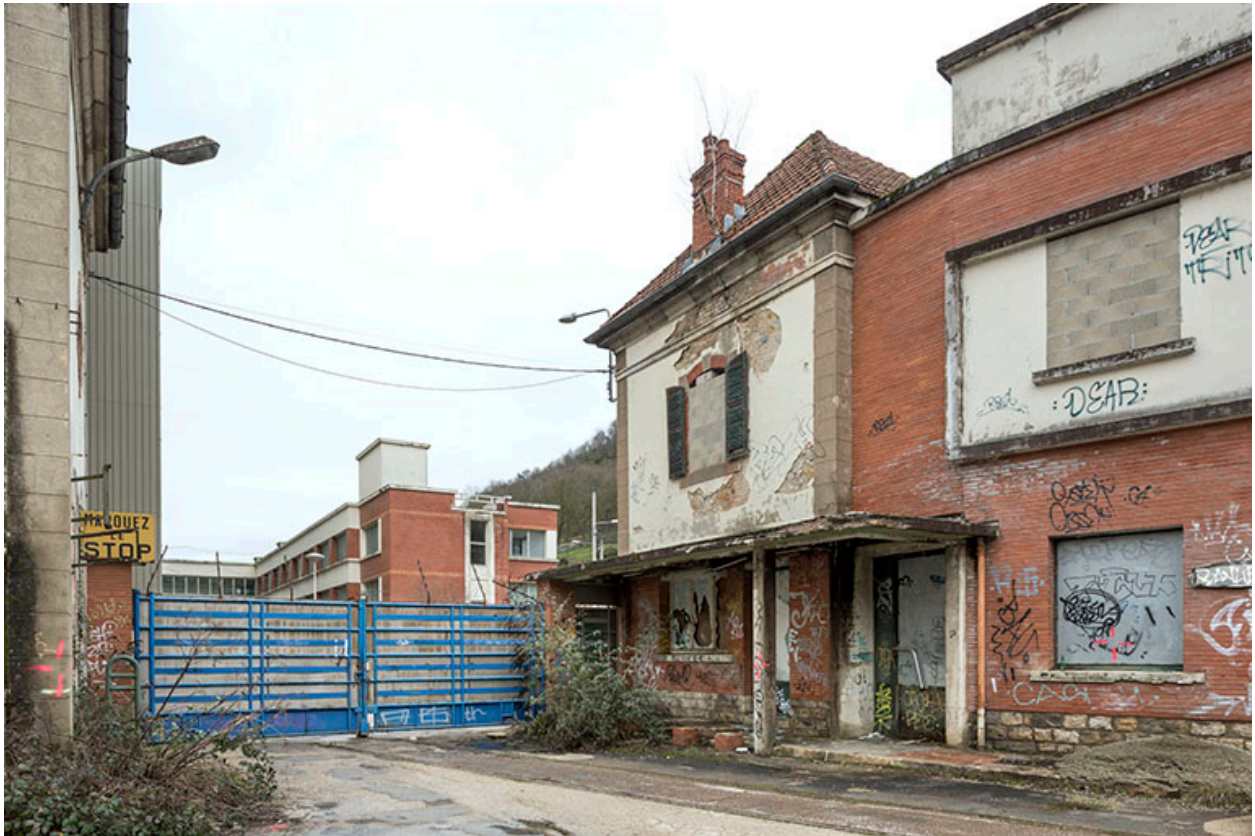
Etat en 2016. Usine A : entrée et façade latérale de la conciergerie, depuis la cour.
