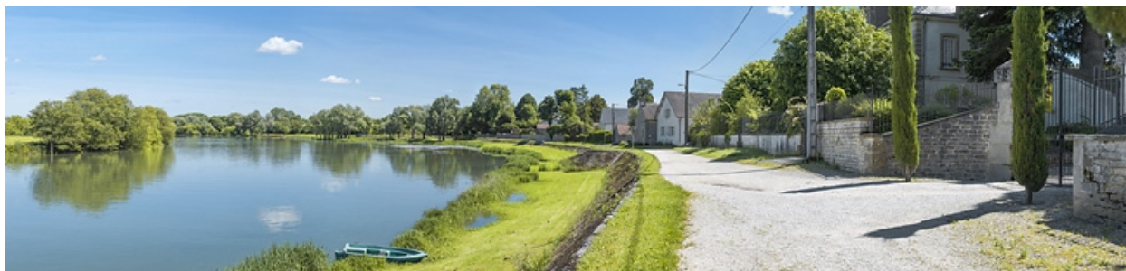
Vue d'ensemble de la digue, prise d'aval.
