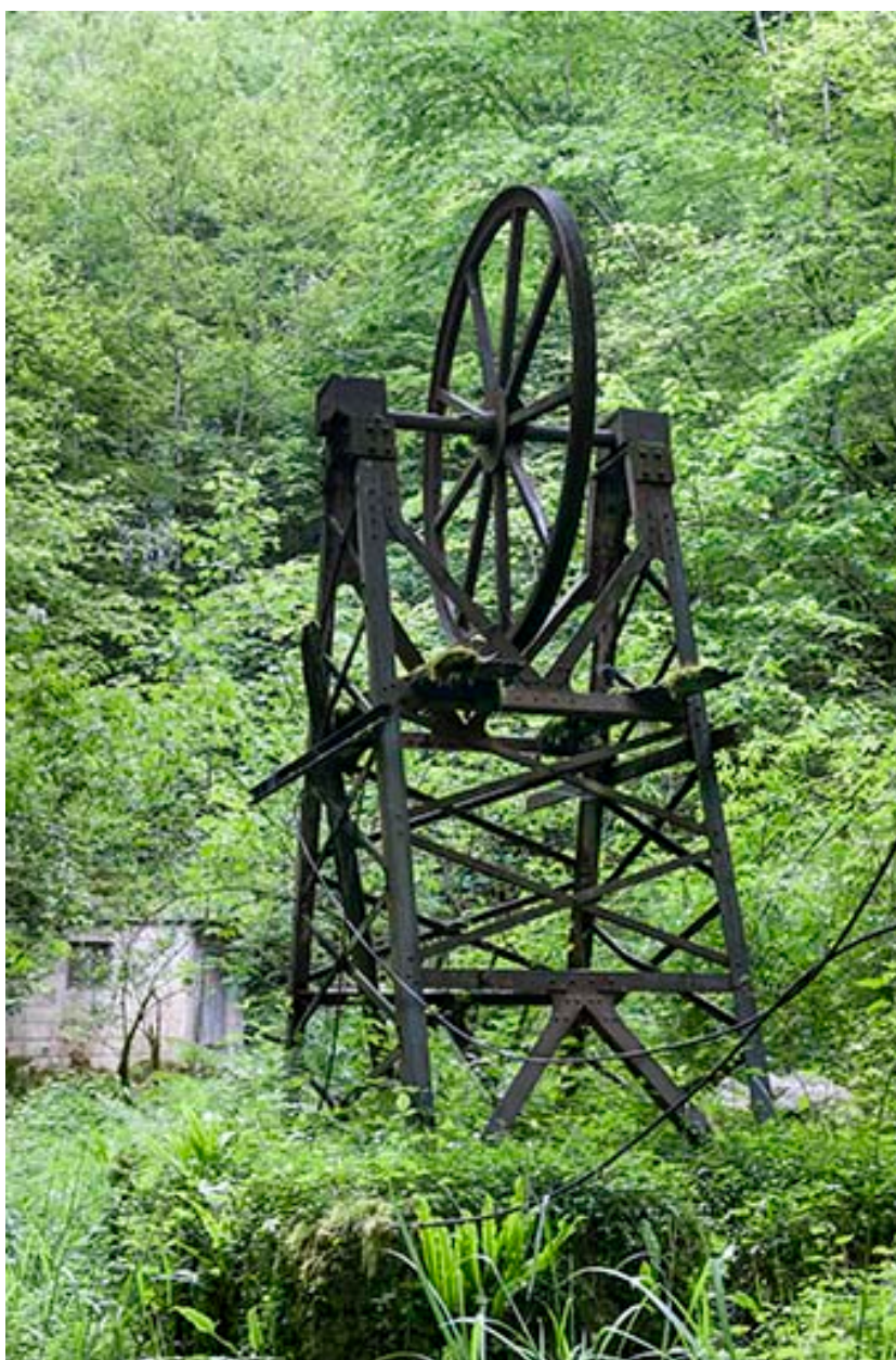
Support métallique (amont) de la transmission par câble.
