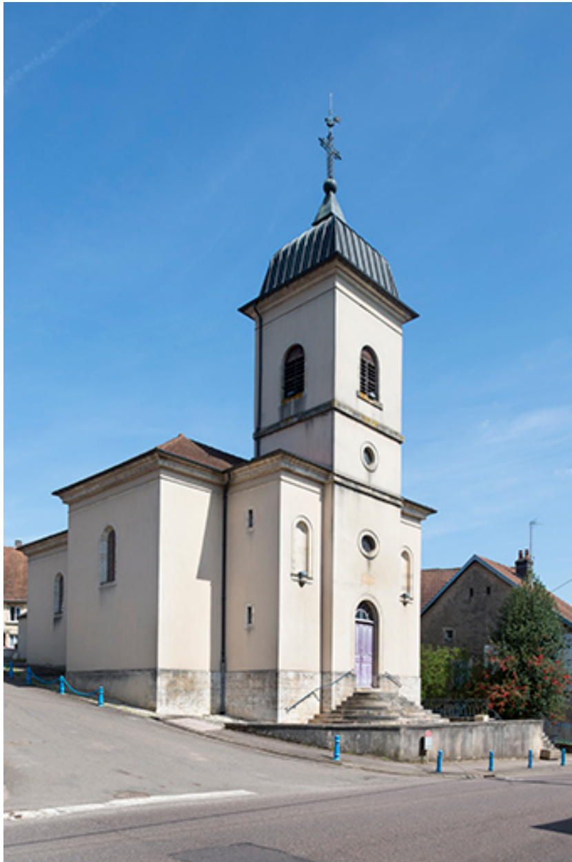
La chapelle depuis la rue Saint-Valère.
