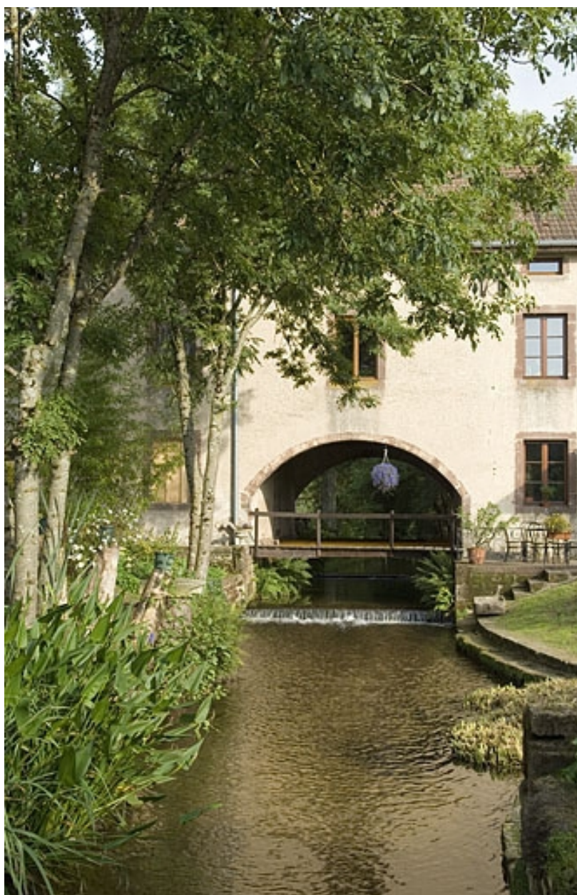
Passage du bief de dérivation sous le bâtiment.
