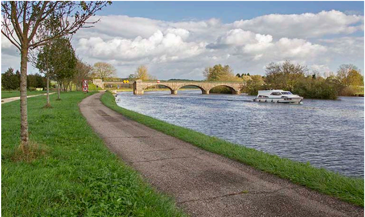
Vue depuis l'aval.
