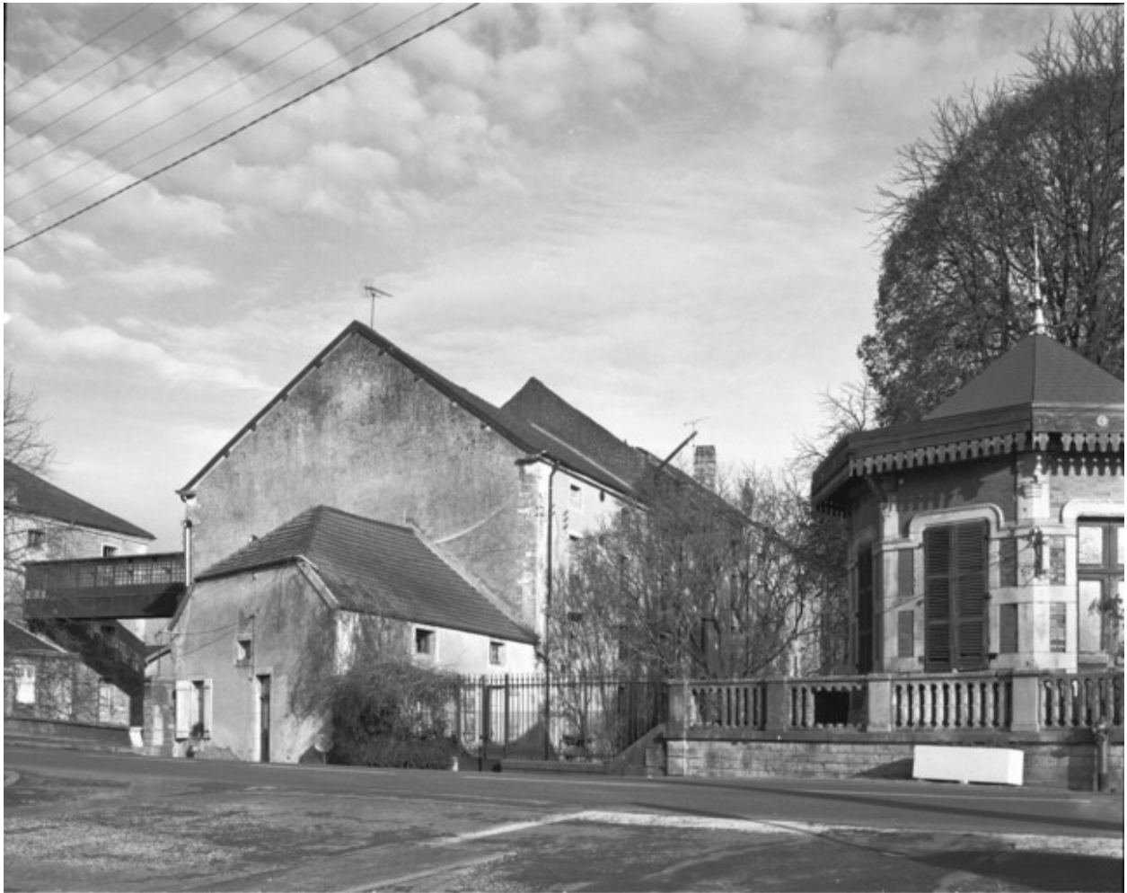
Vue générale de trois quarts droite en 1989.
