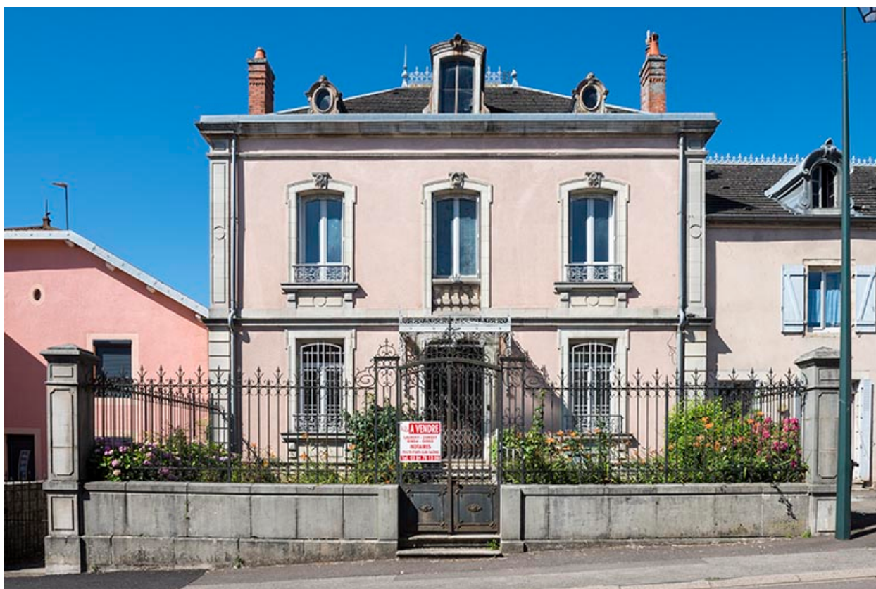
Vue d'ensemble de la façade antérieure.
