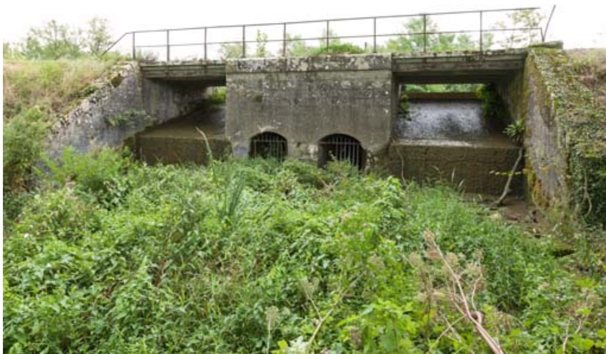
Vue du déversoir.
