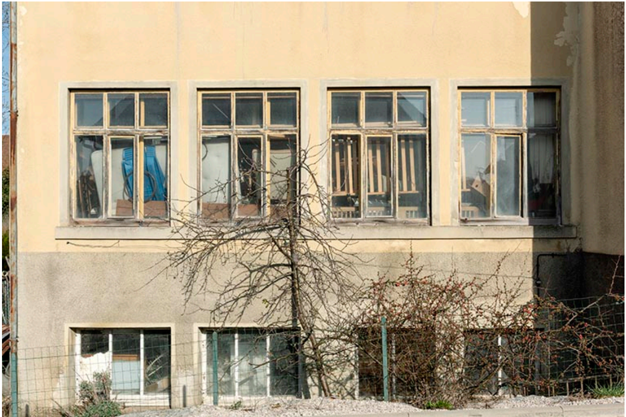
Aile orientale : fenêtres multiples.
