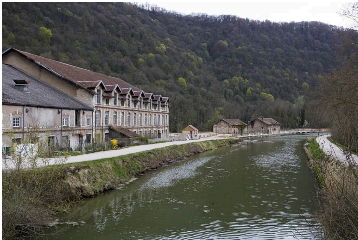
Atelier de façonnage, atelier de réparation et écurie depuis le nord-ouest.
