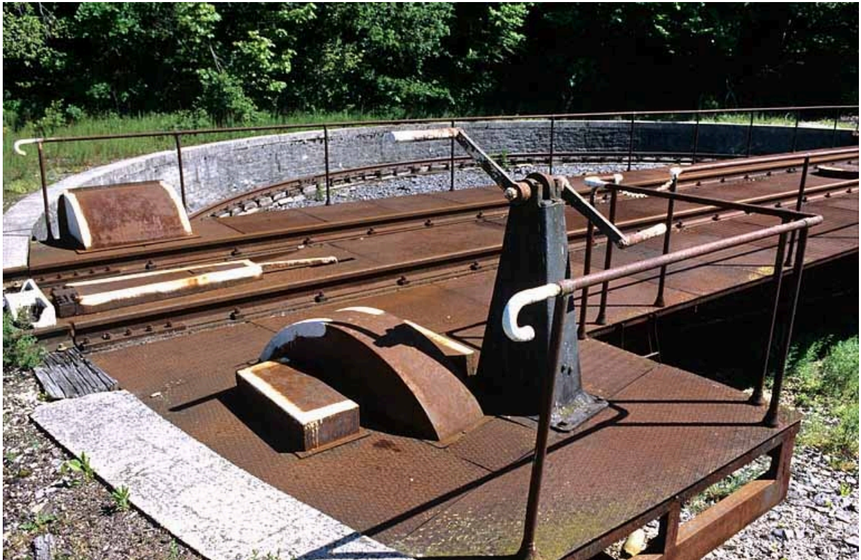
Poste de manoeuvre.
