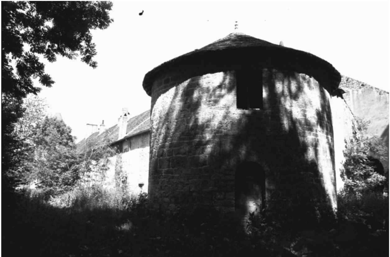
Tour d'enceinte ouest en 1981.
