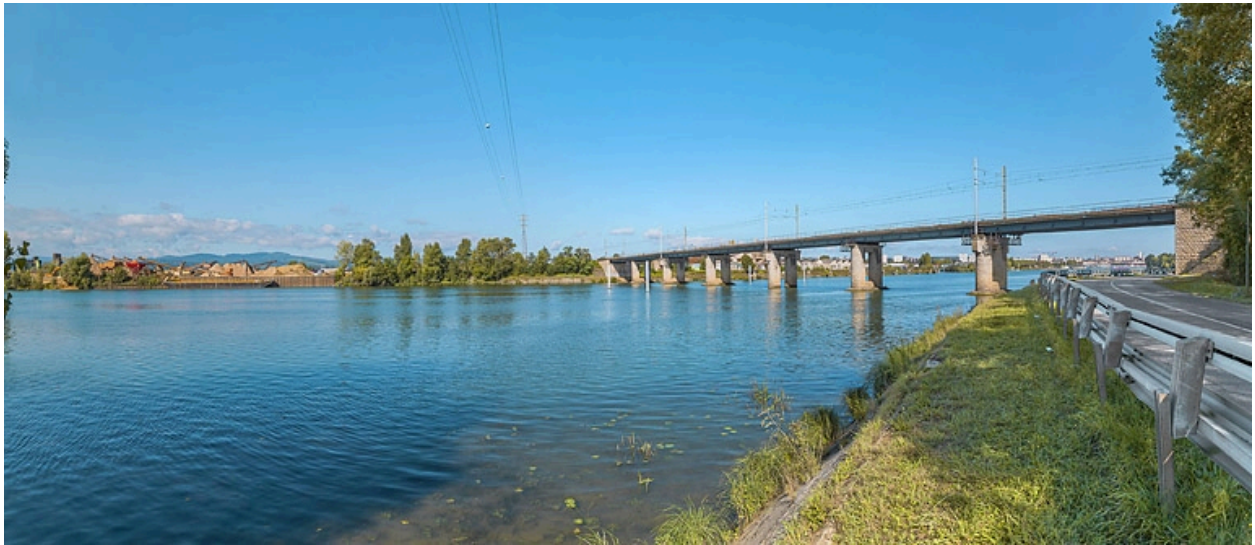
Le pont vu d'aval, rive gauche.
