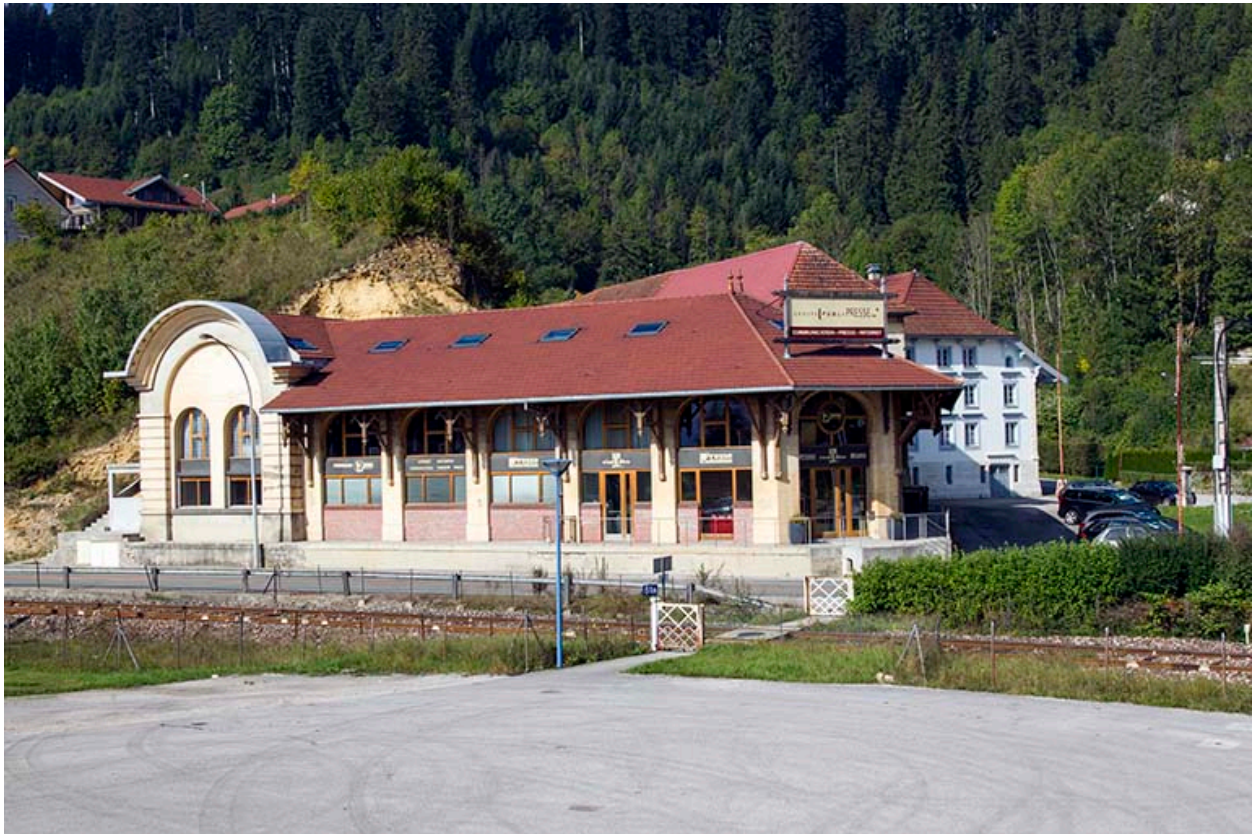
Atelier de conditionnement, depuis l'est.
