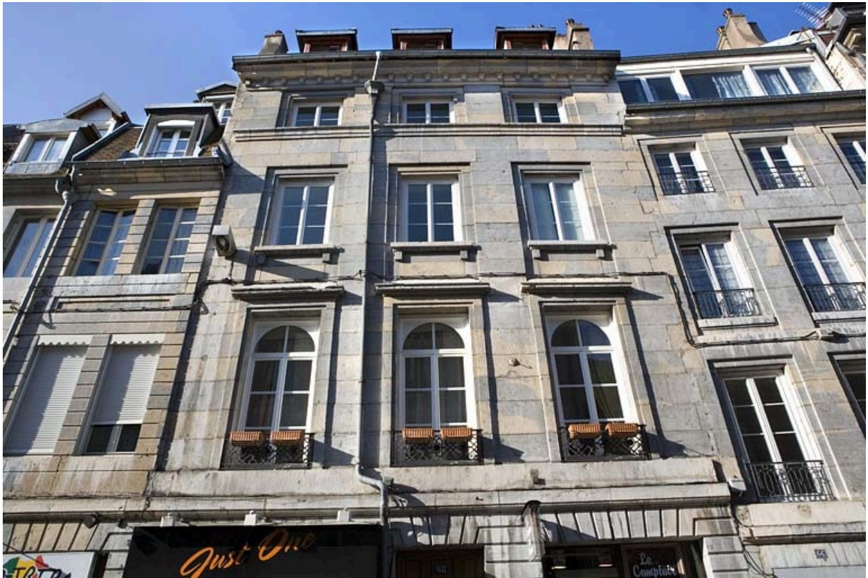
Détail de la façade sur rue au-dessus du rez-de-chaussée, de face.
